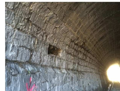
Gewölbe (Quelle: F. Preisig AG)
