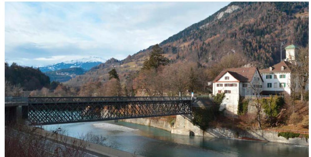
Rheinbrücke Reichenau GR
