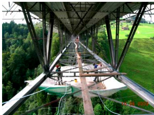
Haggenbrücke bei St. Gallen
