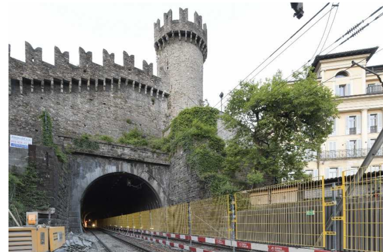
Bahntunnel Svitto mit Burg (Quelle: D. Lupini)
