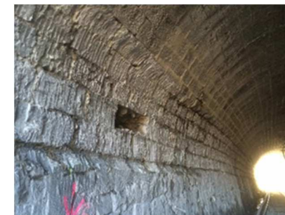
Gewölbe (Quelle: F. Preisig AG)
