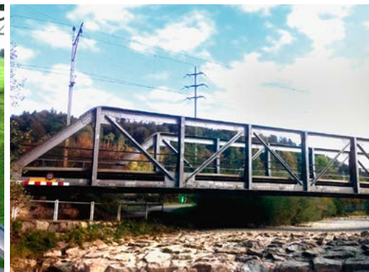
Eisenbahnbrücke Turbenthal-Wila ZH
