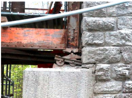
Vorderrheinbrücke Valendas GR
